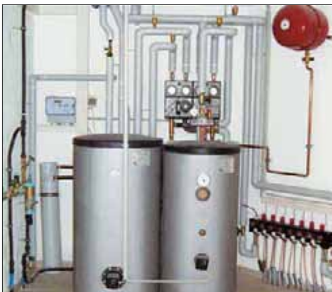
18. ábra. BPS 200 és 300 típusú tartály
