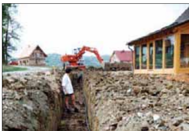
6. ábra. Vízszintes elhelyezés, árokásásos módszerrel
