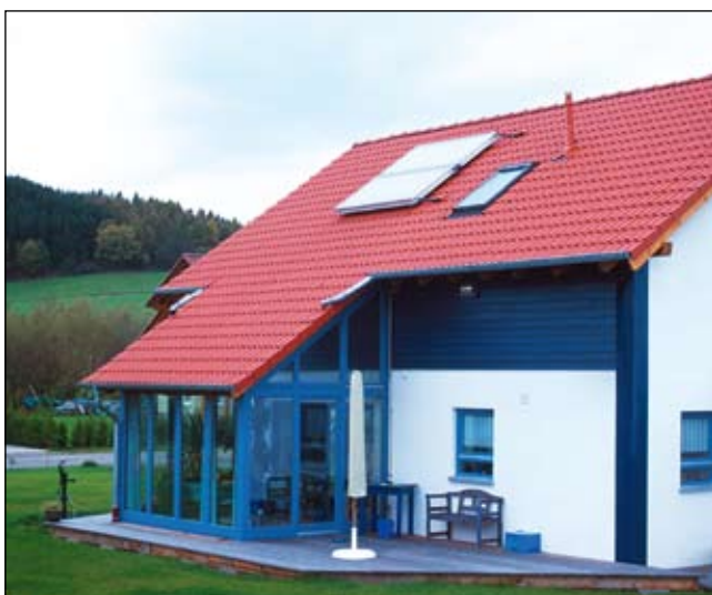
1. kép Tetőre szerelt napkollektor
