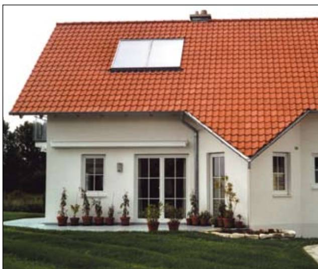
2. kép Tetőbe szerelt napkollektor
